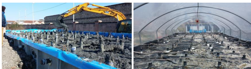
Figura 2. Vasca di trattamento durante il riempimento e in esercizio.
