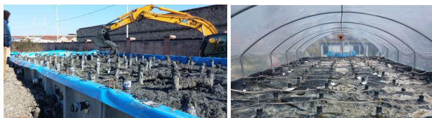
Figura 3: Vasca di trattamento durante il riempimento e ad impianto ultimato
